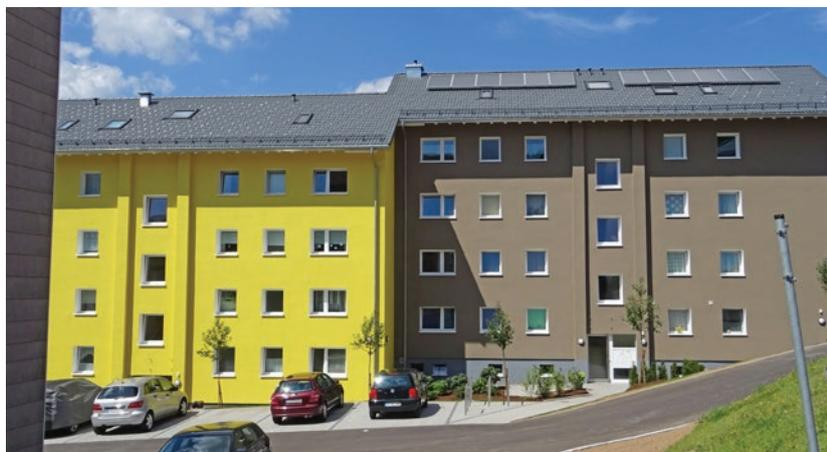
*Die wichtigsten Maßnahmen waren: Fassadendämmung, Dacherneuerung, Anbau neuer Balkone und der Einbau einer thermischen Solaranlage.*
